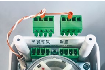
Фото 23. Подключение проводного выключателя
