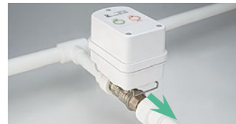
Фото 9. Удаление металлического фиксатора
