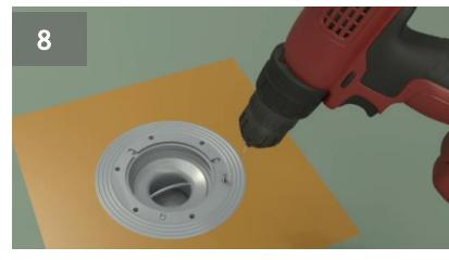
Зафиксируйте фланец и кольцо с помощью винтов (входят в комплект).
