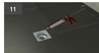
Между карьером решетки и напольным покрытием нанесите слой герметика (например, силикон).
